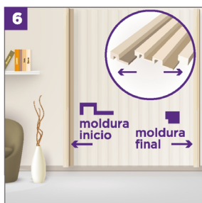
6 Instalación de molduras.
