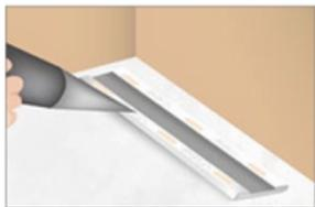
Aplica abundante silicona neutra o cemento de contacto (sin solvente) en la parte posterior del zócalo.
