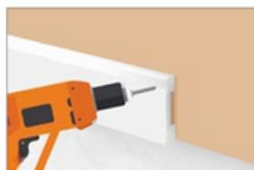
Si deseas utilizar clavos evita colocarlos en la ranura de atrás de los perfiles.
